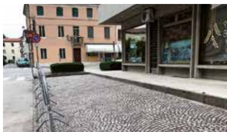
Rifacimento porfido parcheggio Via Fioravanzo (2017) € 6.000
