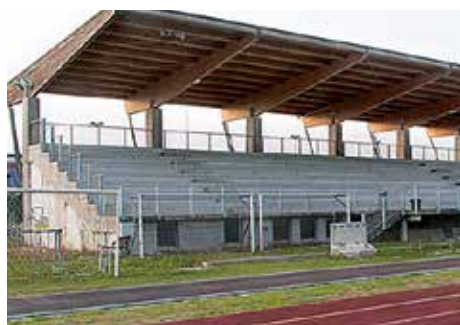
Impianti sportivi sistemazione tribune e sostituzione caldaia (2015) € 40.000
