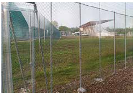
Campo da calcio Via Ferrarin rifacimento recinzione (2015) € 29.000
