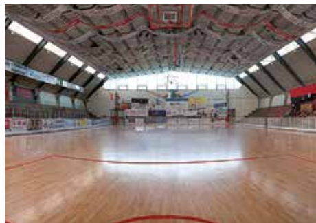
Palazzetto dello Sport via Ferrarin rifacimento pavimentazione (2015) € 61.000
