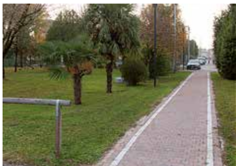
Via Carducci – Via Prati realizzazione attraversamento pedonale (2015) € 3.500
