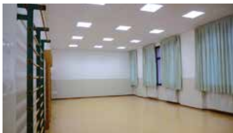
Scuola Primaria Maragnole controsoffitto sala polifunzionale (2017) € 17.300
