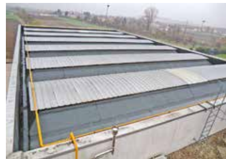
Palestra di Mirabella rifacimento tetto (2017) € 21.500
