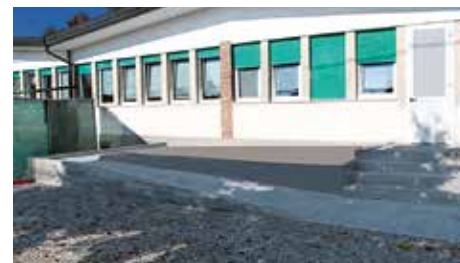
Scuola Infanzia Mirabella realizzazione nuova uscita e rampa d'accesso (2014) € 13.200
