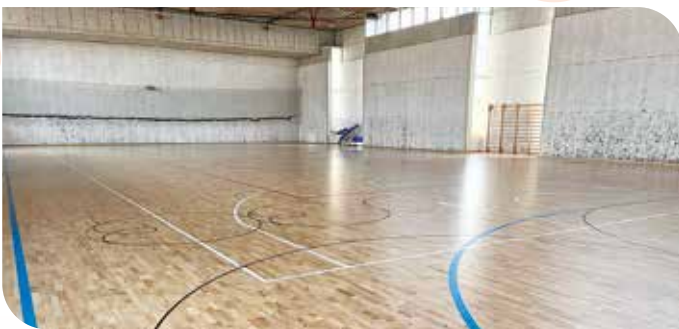
Rifacimento pavimentazione e altri interventi alla palestra dell'istituto Scotton - 2022
