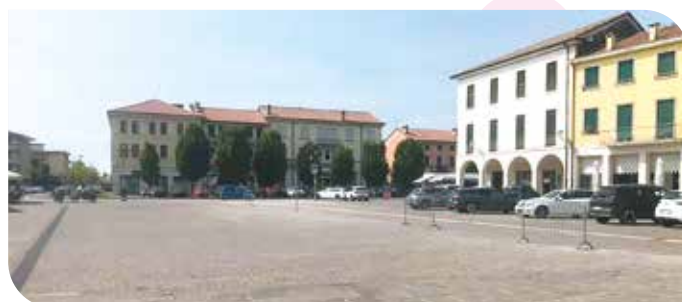
Piazza Mazzini, rifacimento porfido - 2015 e 2016
