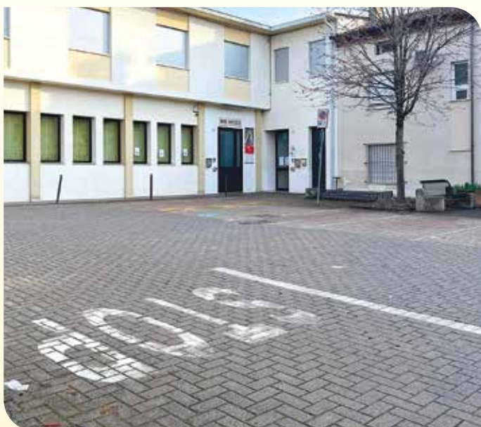
Sistemazione piazzale biblioteca - 2015
