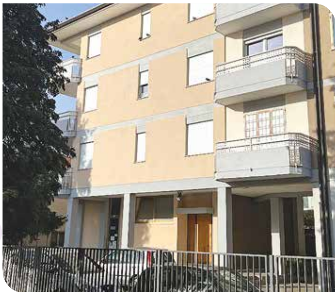
Riqualificazione immobile di via Scifo - 2015 e 2021
