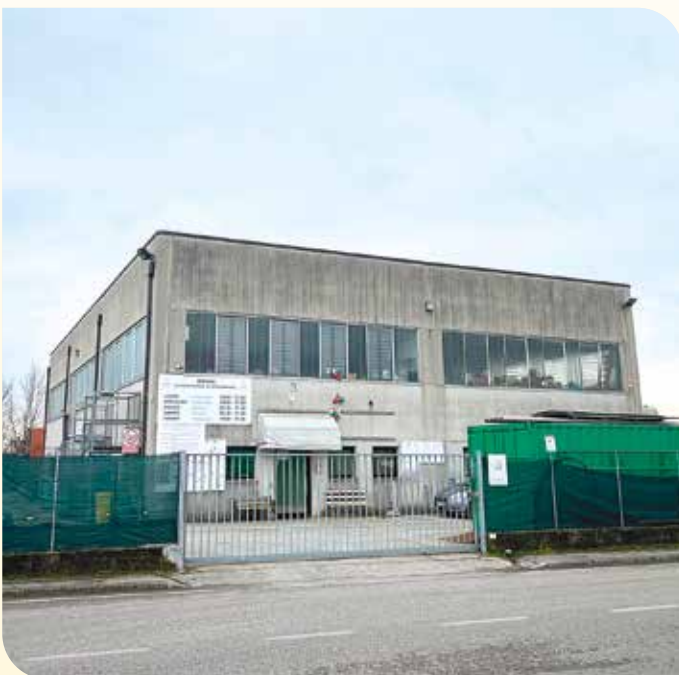
Ecocentro: rifacimento copertura - 2015
