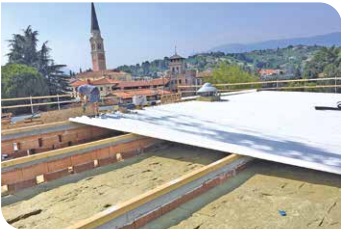
Rifacimento tetto palestra scuole medie - 2017
