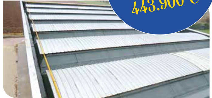
Rifacimento tetto della palestra di Mirabella - 2017
