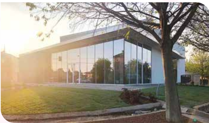
La sala polifunzionale "Alda Merini" - 2019
