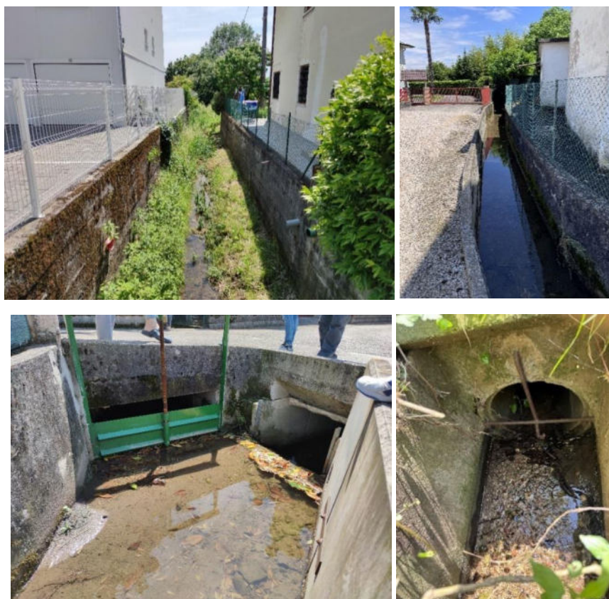
Figura 2.2. Cambiamento di sezione della roggia scendendo verso valle
