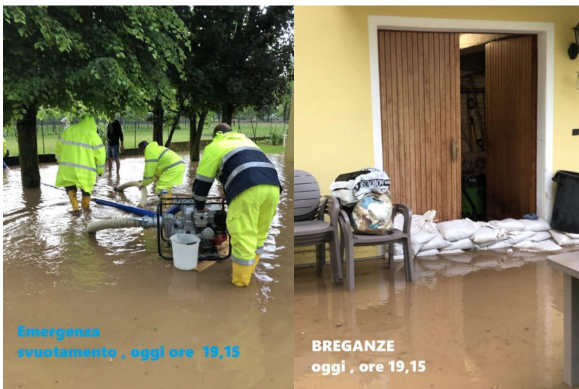
Figura 2.8. Foto del giardino dell'abitazione di Via Riva 33 nel corso dell'evento piovoso
