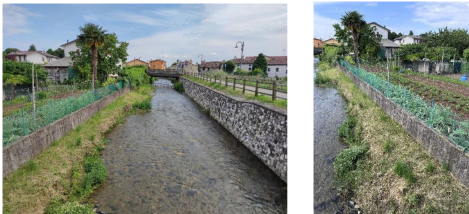
Figura 2.10. Argine sinistro Torrente Chiavon
