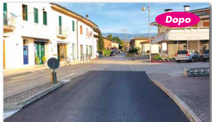
Manto stradale della rotatoria di Maragnole
