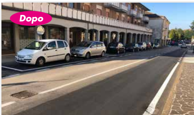
Manto stradale di via Riva
